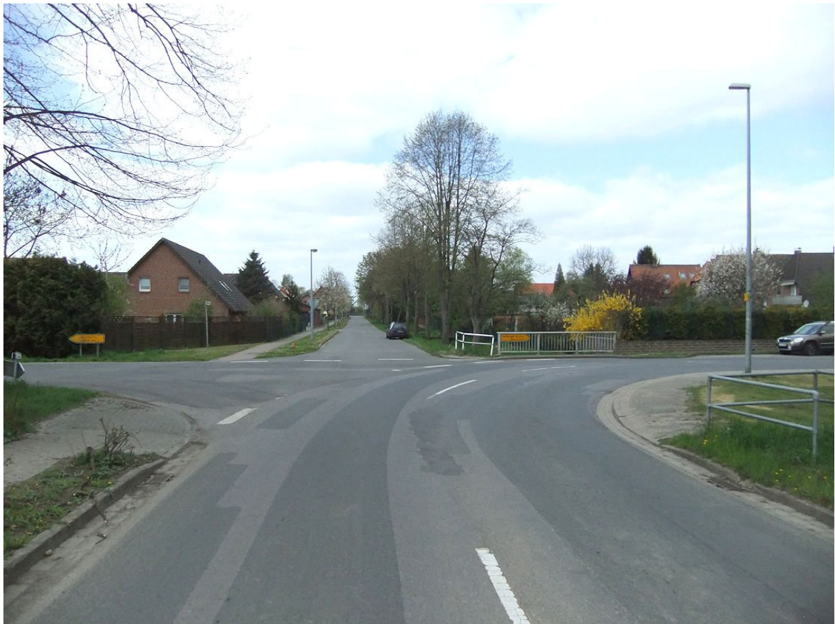
Die Ortsdurchfahrt der L 477 in Soßmar erscheint übermäßig verkehrsgerecht ausgebaut; zudem sind Teile der Nebenanlagen abgängig. Die Kreuzung mit der K 37 bzw. mit dem Hirtenweg sollte deutlicher betont werden.
