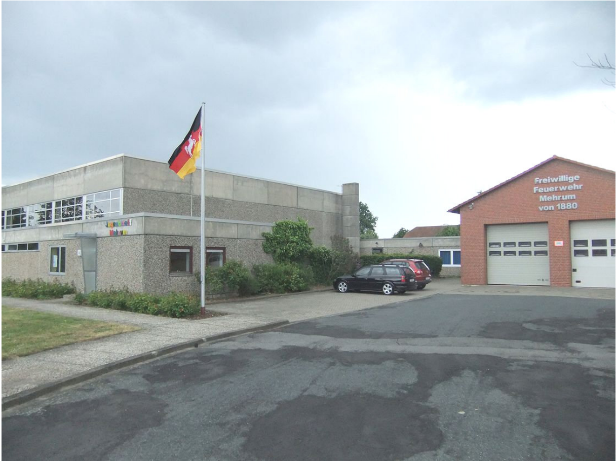
Die Gestaltung und Neuausbau der Außenanlage an der Feuerwehr sowie vom Vorplatz an der Sporthalle zählen zu den vordringlichsten Maßnahmen in Mehrum.
