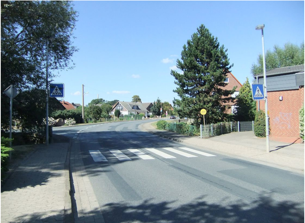
In Equord sollte die Fußgängerüberquerung etwas in nördliche Richtung verlegt werden, um die Einsehbarkeit in die Landesstraße zu verbessern. Optimale Sicherheit ergäbe sich durch eine Bedarfsampel.
