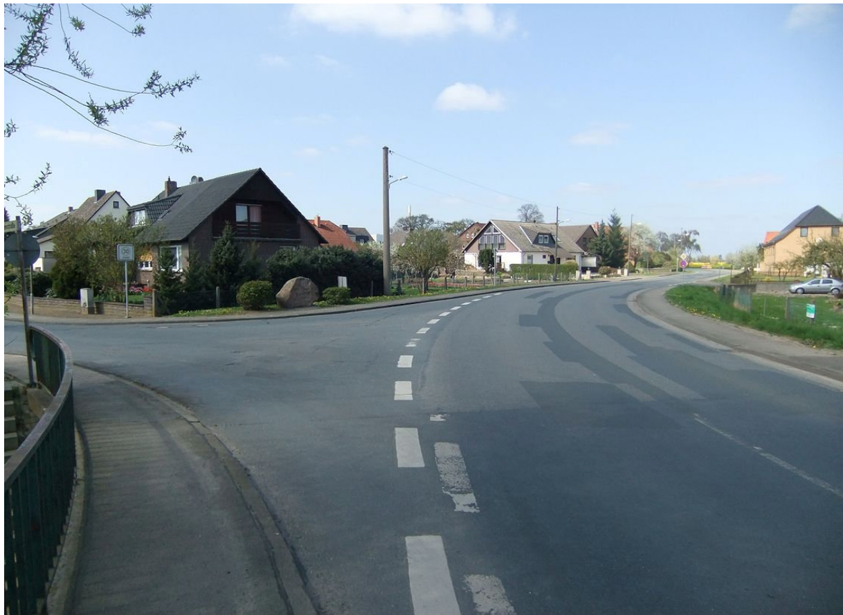
Die Einmündungsbereiche und die Nebenanlagen der Ortsdurchfahrt in Equord sind teilweise übermäßig ausgebaut und wenig gegliedert.
