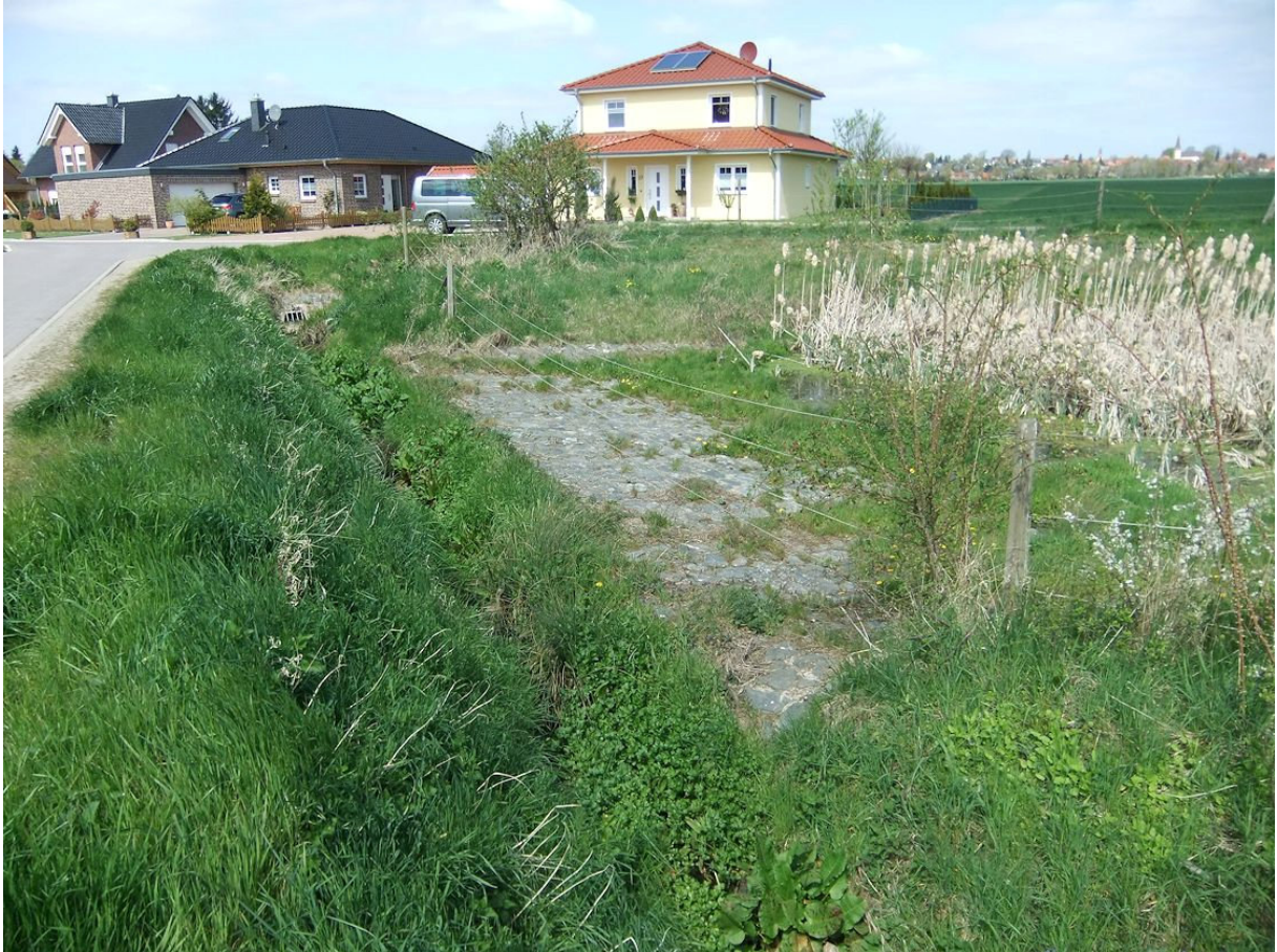
Das östlich von Soßmar angelegte Regenrückhaltebecken erweist sich für größere Niederschlagsmengen als zu klein. Die Beeke verfügt innerörtlich lediglich über ein begrenztes Retentionsvolumen.
