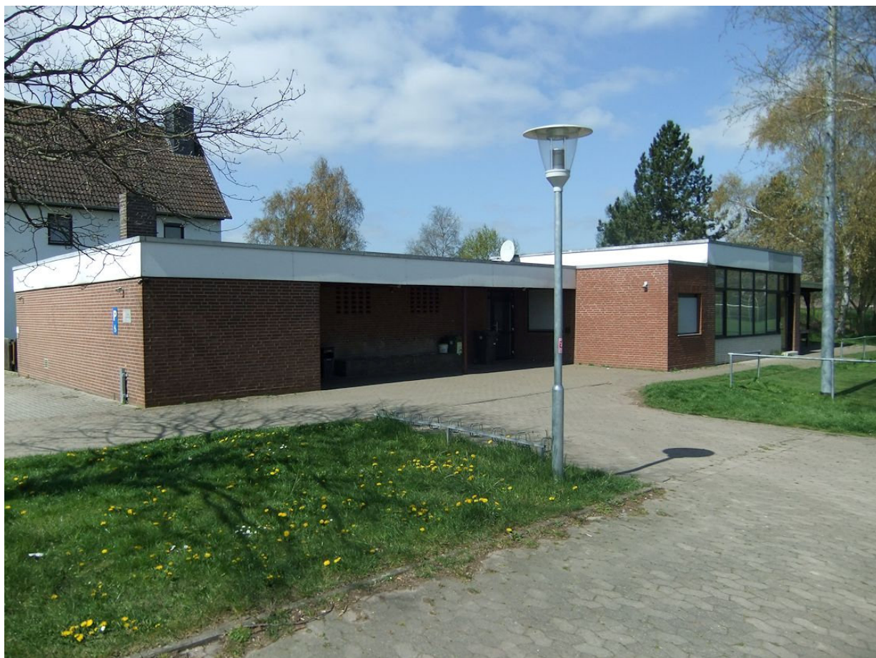
Das Mehrzweckgebäude in Soßmar verfügt über kein behindertengerechtes WC - hierfür soll im Eingangsbereich ein kleinteiliger Anbau erfolgen.
