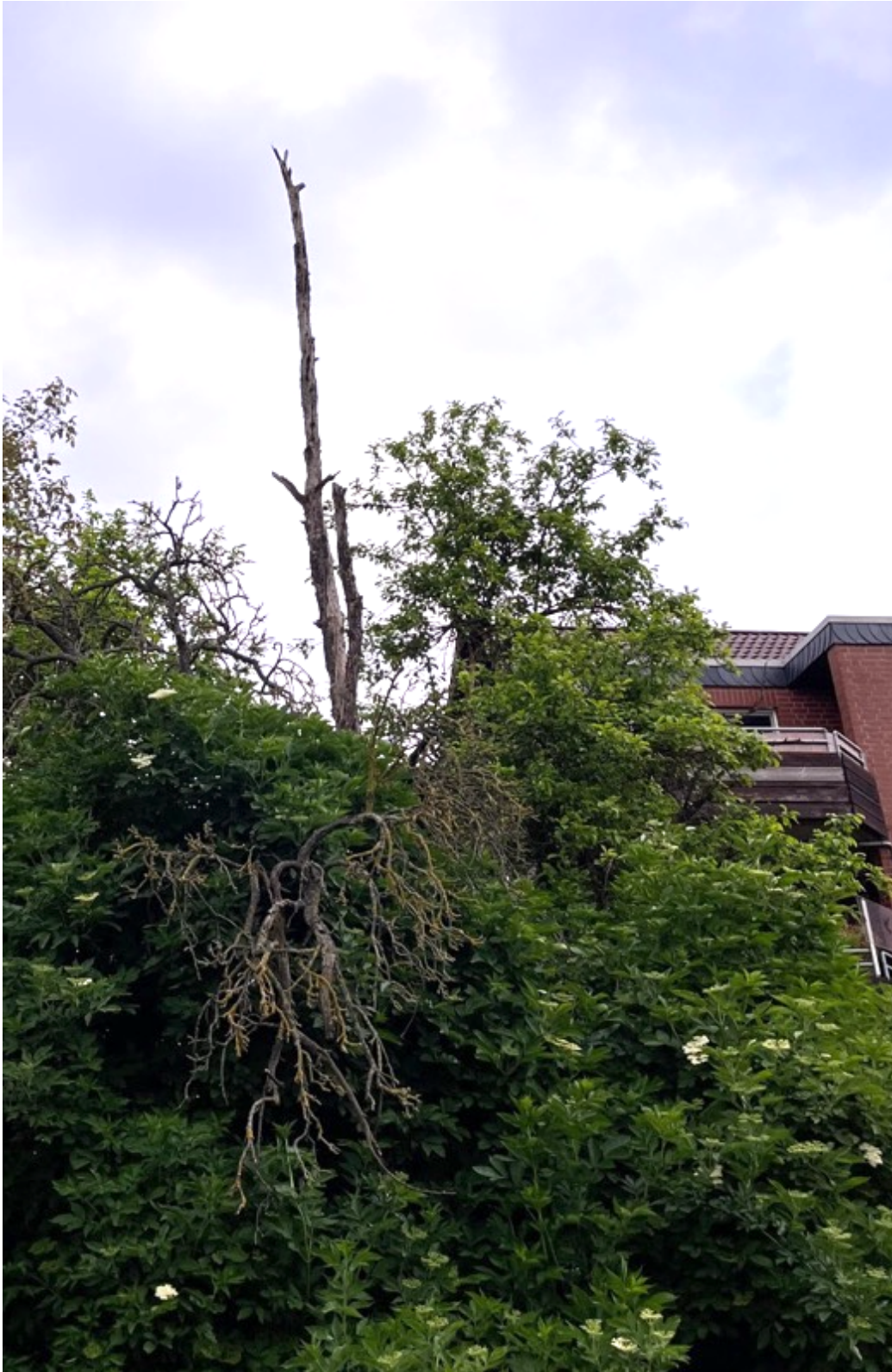
Abbildung 6: Baum 7, Totholz, abgeplatzte Rinde
